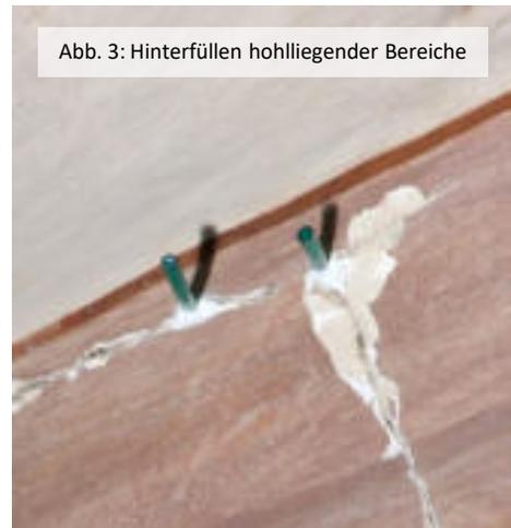
Abb. 3: Hinterfüllen hohlliegender Bereiche
