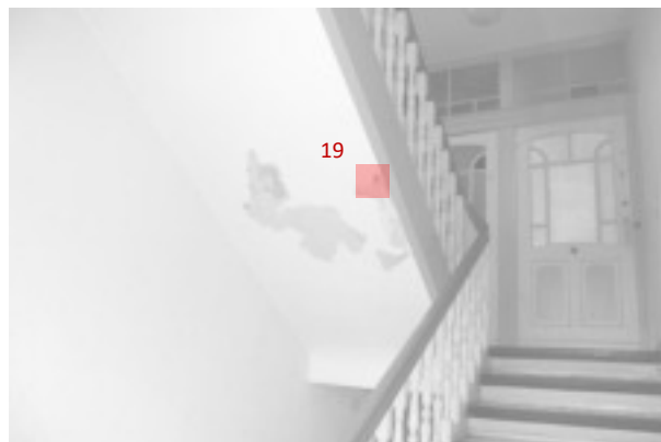
Untersicht, Höhe OG 4
