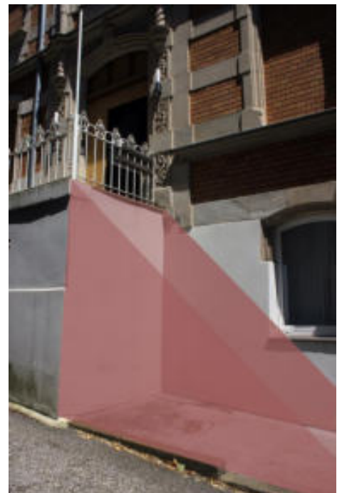
Abb. 26 ▶: Mögliche frühere Position der Treppenstufen
