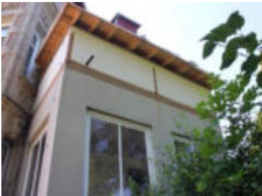
▲ Abb. 4: Die auf Höhe OG 1 sichtbaren Eisenträger
