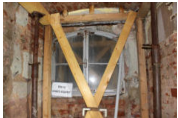
Abb. 15: Das vermutlich bauzeitliche Fenster öffnet sich unter die Stufen
