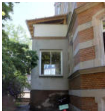
◀ Abb. 2 und 3: Der Wintergartenbau zum Zeitpunkt der Untersuchung. Bis zum Beginn der eigentlichen Sanierung war ein Notdach installiert.
