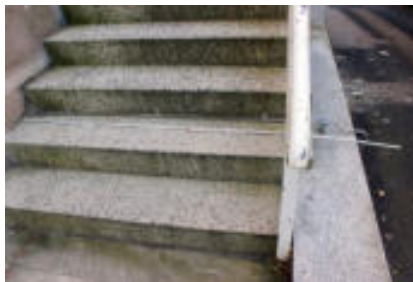
Abb. 12: Die momentan verbauten Stufen
